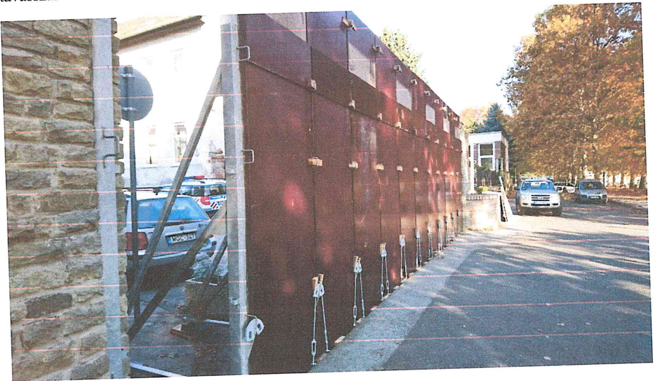
2. ábra mobilgát út-lejárói szakasza
